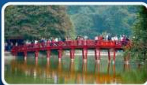
สะพานแสงอาทิตย์
